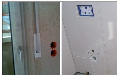
Holzrahmenbau bis hin zu Fenster, Rollläden, Elektro- und Sanitärvorinstallation.
