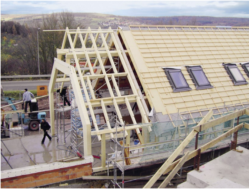
Die Dach- und Wandkonstruktion der früheren Wirtschaftsgebäude wurde komplett wiederaufgebaut
